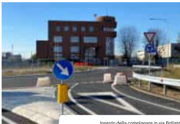
Innesto della complanare in via Bollate
