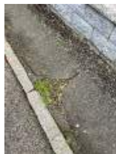
B1.4 dissesto pavimentazione
