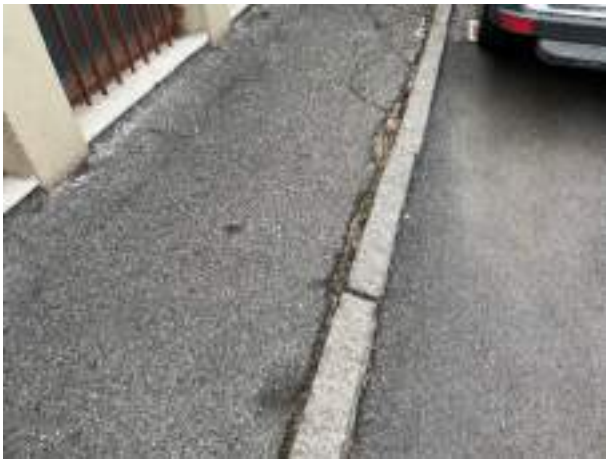
B1.4 pavimentazione dissestata
