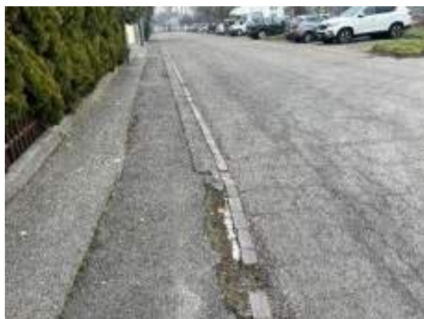
B1.4 pavimentazione dissestata
