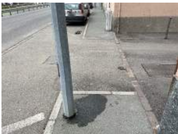
B1.6 mancanza attraversamento pedonale
