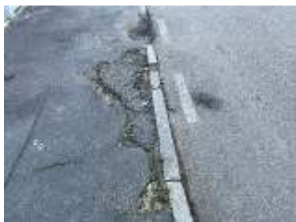
B1.4 pavimentazione dissestata
