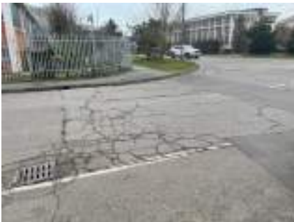
B1.6 mancanza attraversamento pedonale
