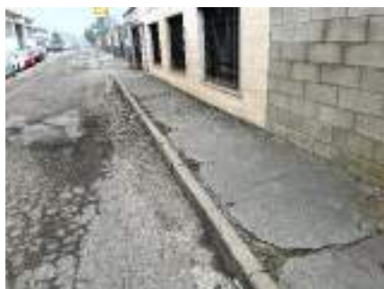
B1.4 pavimentazione dissestata
