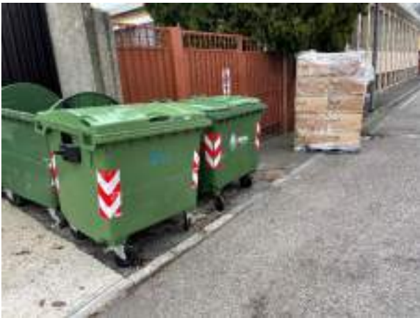
B1.4 pavimentazione dissestata
