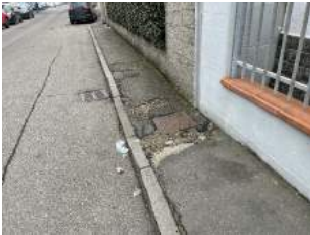
B1.4 pavimentazione dissestata
