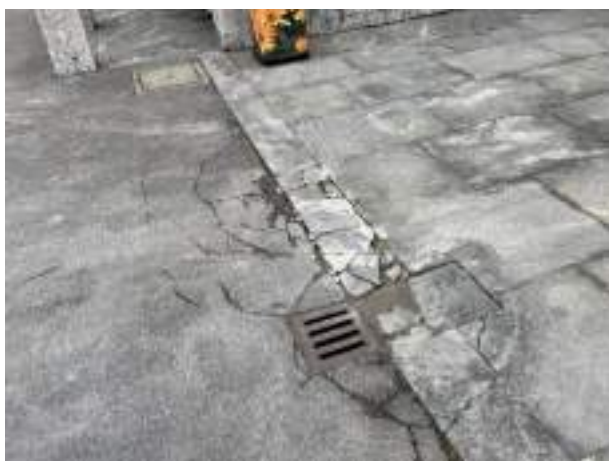
B1.4 pavimentazione dissestata
