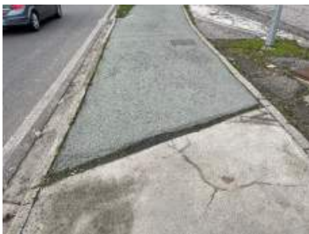
B1.4 pavimentazione dissestata
