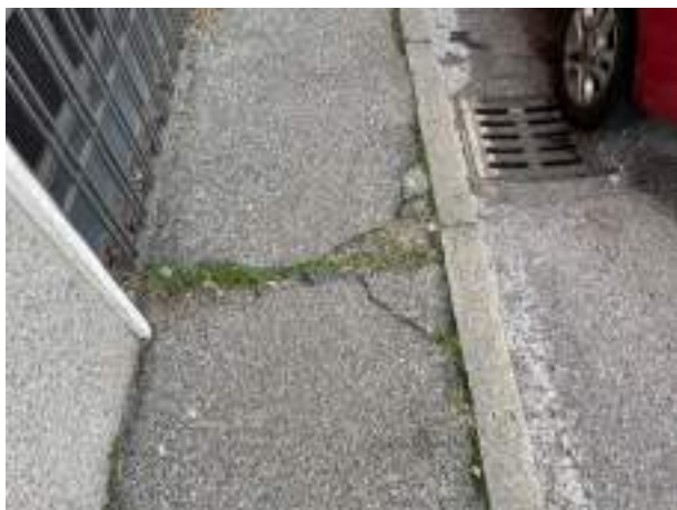
B1.4 pavimentazione dissestata
