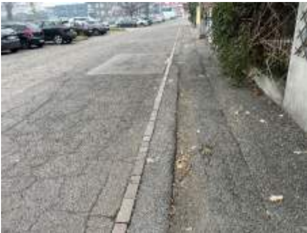
B1.4 pavimentazione dissestata
