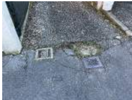
B1.5 pozzetto non in quota
