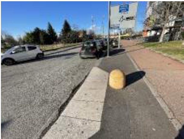
B1.4 pavimentazione dissestata
