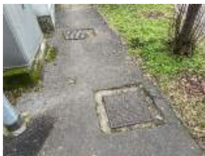
B1.5 pozzetto non in quota
