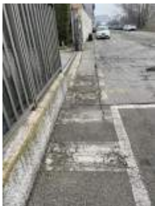
B1.4 pavimentazione dissestata
