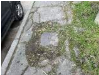
B1.4 pavimentazione dissestata
