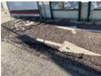
B1.4 pavimentazione dissestata
