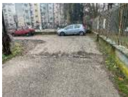
B1.4 dissesto pavimentazione
