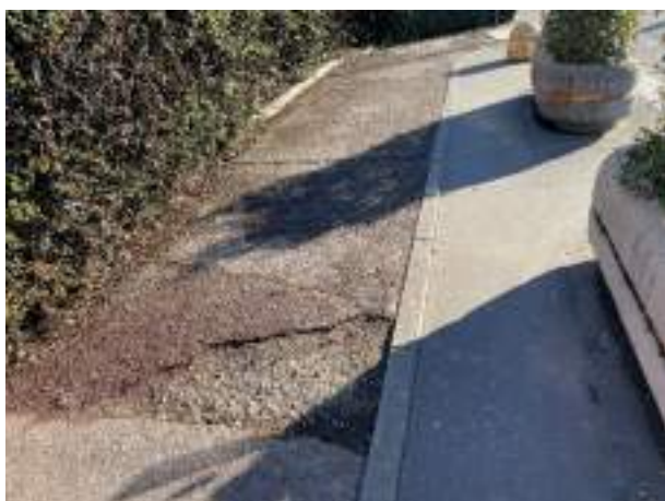
B1.4 pavimentazione dissestata
