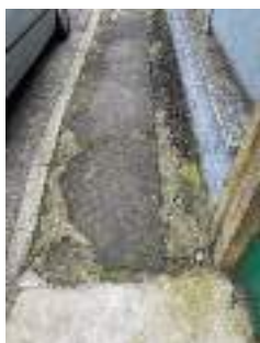
B1.4 pavimentazione dissestata
