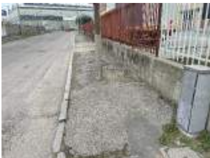
B1.4 pavimentazione dissestata
