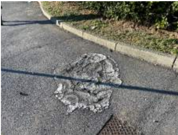
B1.4 pavimentazione dissestata
