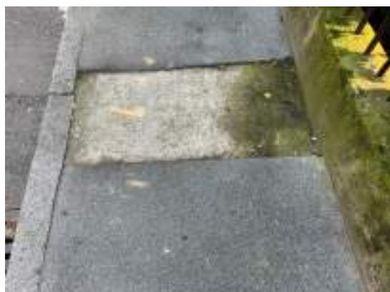
B1.4 pavimentazione dissestata
