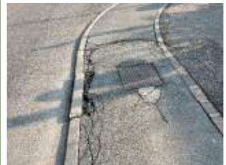
B1.4 dissesto pavimentazione
