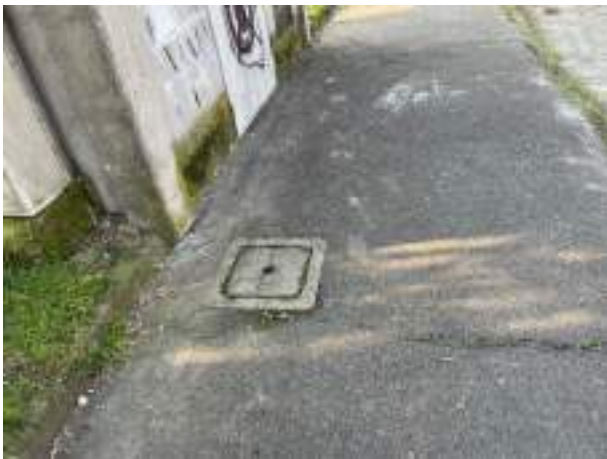
B1.5 pozzetto non a norma
