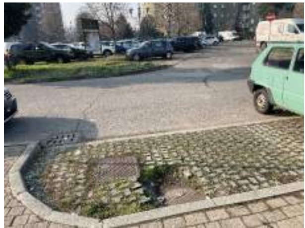
B1.5 pozzetto non in quota
