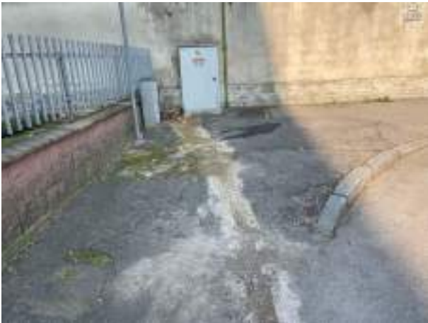
B1.4 dissesto pavimentazione
