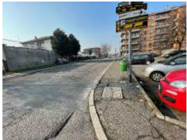
B1.5 pozzetto non in quota
