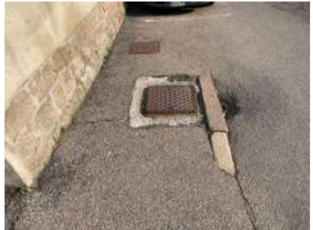
B1.5 pozzetto non in quota
