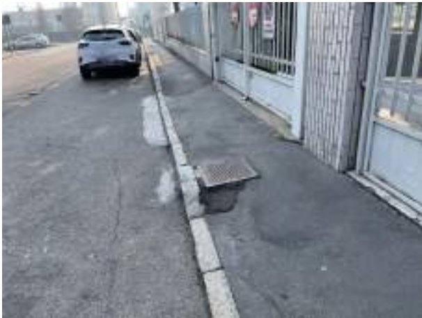
B1.5 pozzetto non a norma
