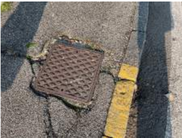
B1.5 pozzetto non a norma
