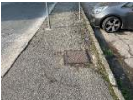
B1.4 dissesto pavimentazione
