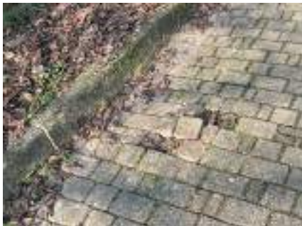
B1.4 pavimentazione dissestata
