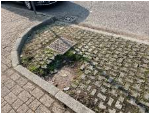
B1.4 dissesto pavimentazione
