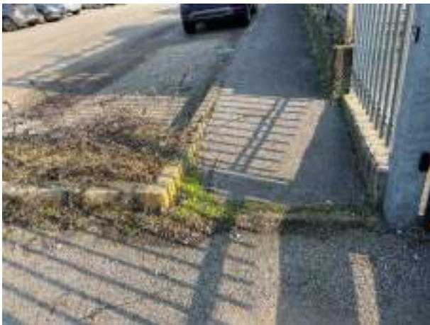
B1.4 pavimentazione dissestata
