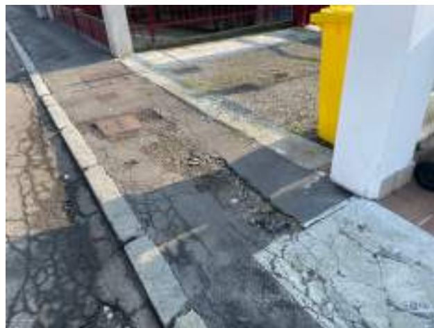
B1.4 pavimentazione dissestata
