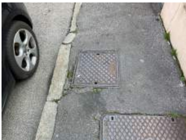
B1.5 pozzetto non a norma
