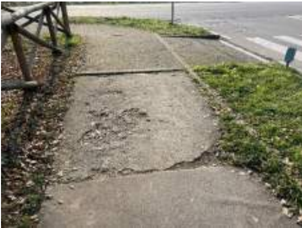
B1.4 pavimentazione dissestata
