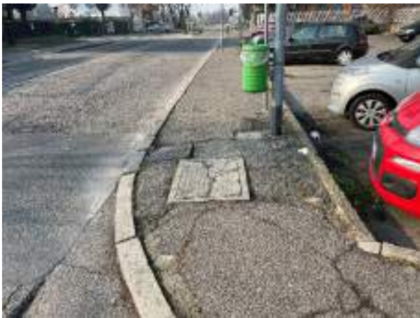
B1.4 dissesto pavimentazione
