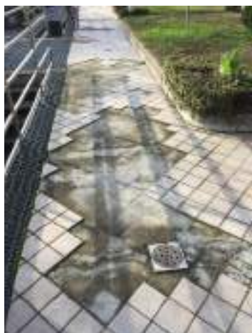
B1 -4 Pavimentazione sconnessa e degradata
