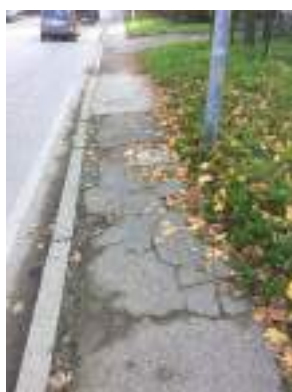
B1- 4 Pavimentazione sconnessa
