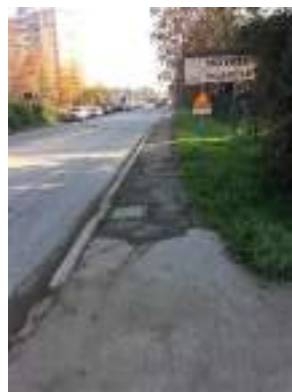
B1- 4 Pavimentazione degradata
