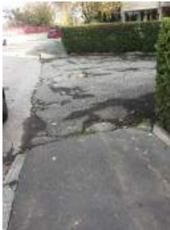
B1 -4 Pavimentazione degradata
