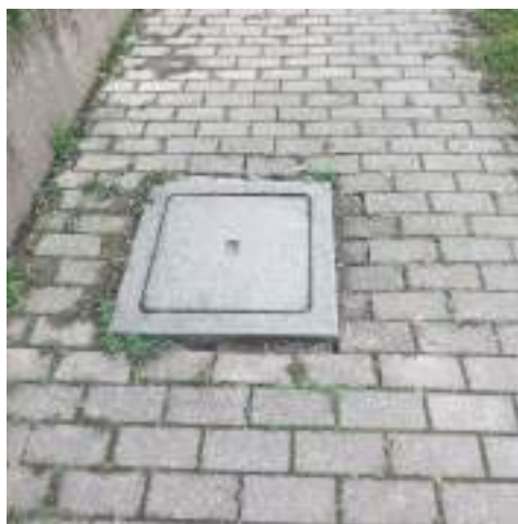
B1-5 Pozzetto in sporgenza
