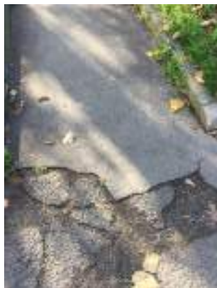
B1 -4 Pavimentazione sconnessa
