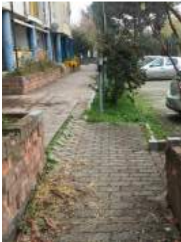
B1-4 Percorso pedonale degradato e sconnesso
