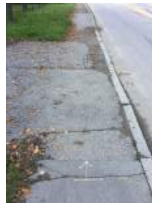
B1 -4 Pavimentazione sconnessa
