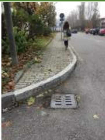
B1-7 Percorso pedonale con dislivello > 2,5 cm
