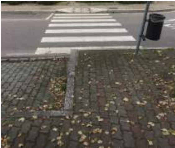
B1-7 Percorso pedonale con dislivello > 2,5 cm
