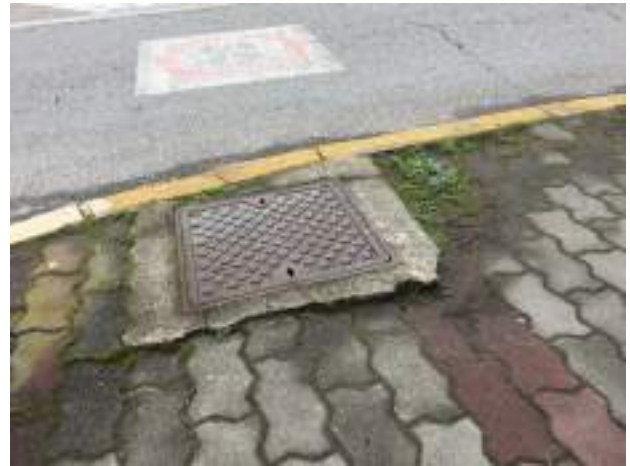
B1-5 Pozzetto in sporgenza
