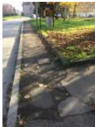
B1 -4 Pavimentazione sconnessa
