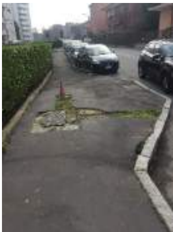
B1 -4 Pavimentazione sconnessa
