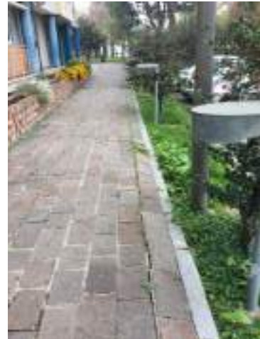
B1-4 Percorso pedonale degradato e sconnesso
