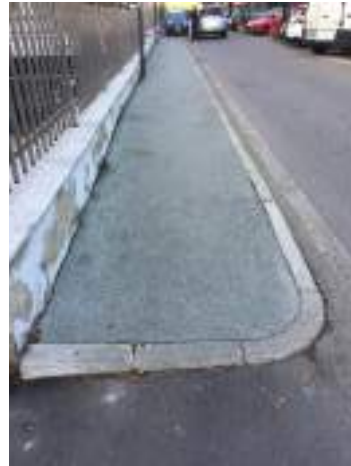
B1-21 Attraversamento pedonale privo di segnaletica orizzontale
