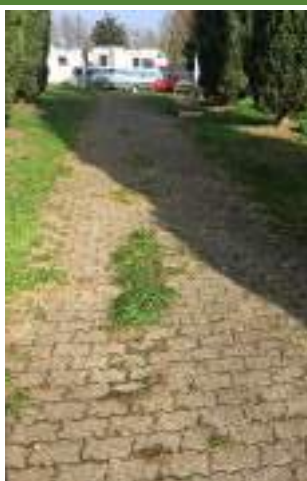
B1-4 Pavimentazione degradata
