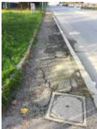
B1 -4 Pavimentazione sconnessa
