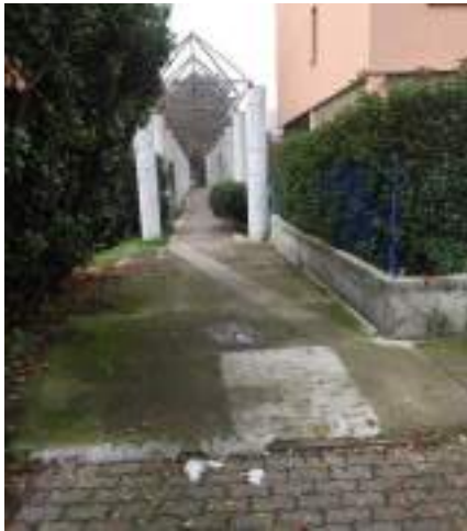
B1 – 4 Percorso pedonale degradato e sconnesso
