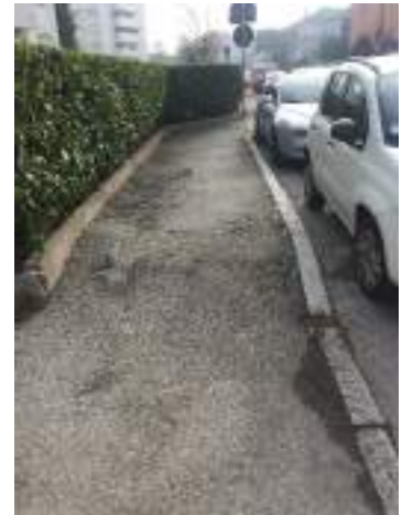
B1 -4 Pavimentazione sconnessa
