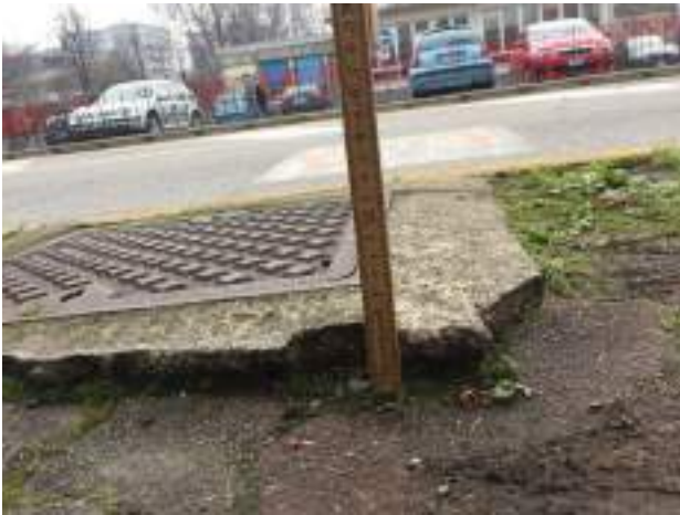
B1-5 Pozzetto in sporgenza
