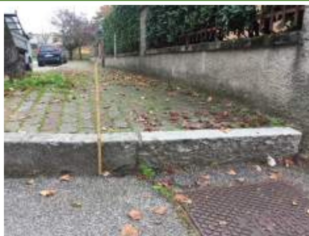
B1-7 Manca rampa per superamento dislivello >2,5 cm
