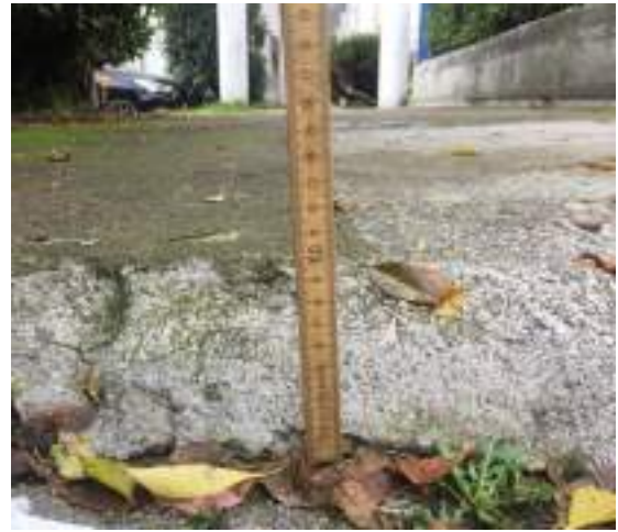
B1 – 7 Percorso pedonale con dislivello > 2,5 cm
