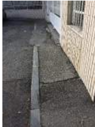
B1 – 4 dissesto pavimentazione
