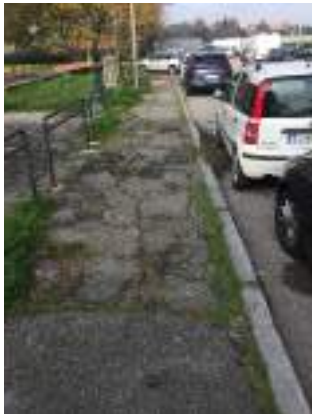
B1 -4 Pavimentazione degradata
