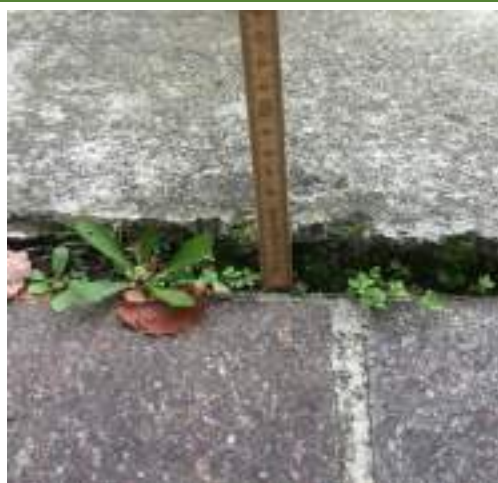
B1 – 7 Percorso pedonale con dislivello > 2,5 cm
