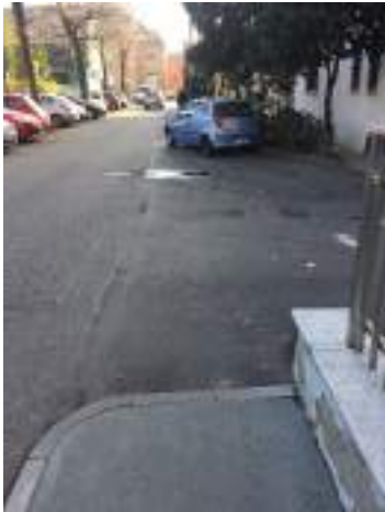
B1 -7 Percorso pedonale con dislivello > 2,5 cm
