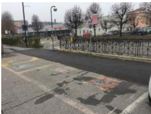
B1.20 mancanza segnaletica orizzontale dei parcheggi delle categorie protette
