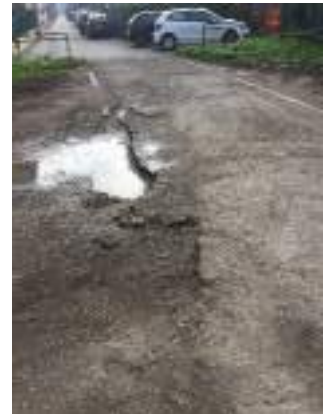
B1 -4 Pavimentazione degradata
