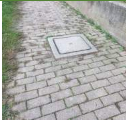
B1-5 Pozzetto in sporgenza
