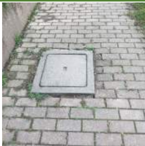
B1-5 Pozzetto in sporgenza
