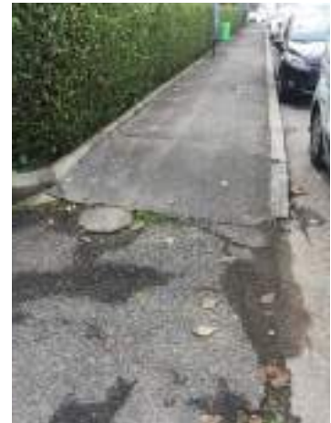
B1 -4 Pavimentazione degradata
