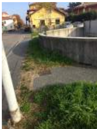
B1 – 4 Pavimentazione dissestata
