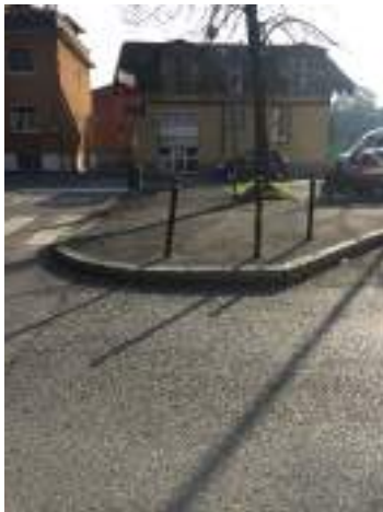
B1 -7 Percorso pedonale con dislivello > 2,5 cm
