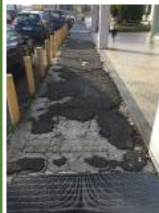
B1-4 pavimentazione dissestata
