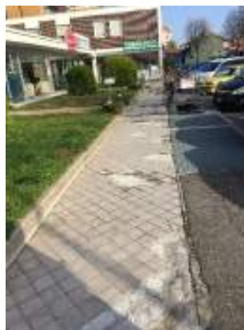
B1 -4 Pavimentazione sconnessa e degradata
