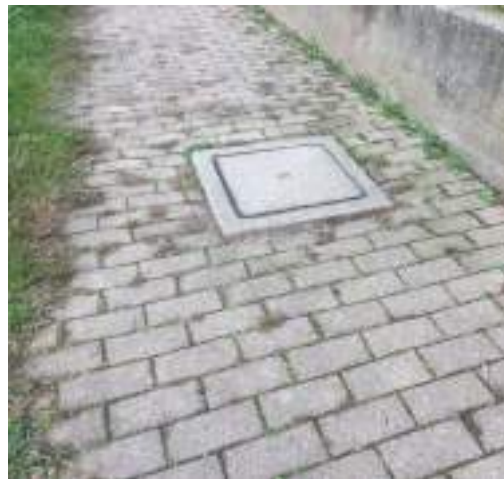
B1-5 Pozzetto in sporgenza
