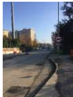
B1- 4 Pavimentazione degradata
