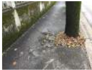
B1.4 pavimentazione degradata e sconnessa a causa delle radici
