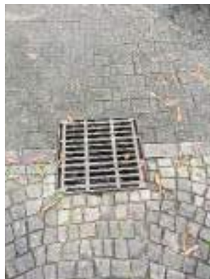
B1.4 Pavimentazione dissestata e sconnessa
