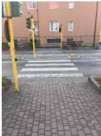
B1-6 Mancanza segnaletica tattile in corrispondenza dell'attraversamento pedonale semaforizzato
