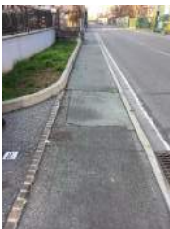
B1 – 4 Percorso pedonale degradato e sconnesso
