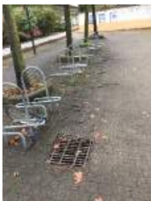
B1.4 Pavimentazione dissestata e sconnessa
