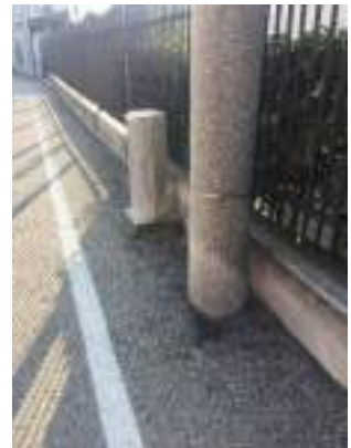
B1.1 Percorso pedonale <90 cm
