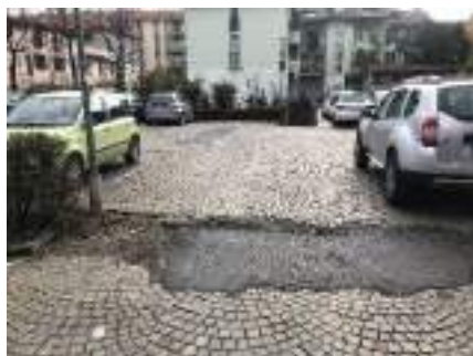
B1.4 dissesto pavimentazione
