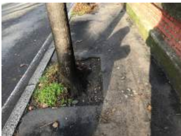
B1.4 dissesto pavimentazione
