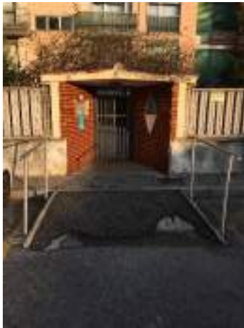
B1.4 – pavimentazione degradata e disconnessa
