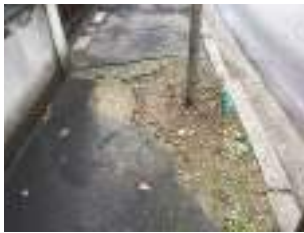
B1.4 pavimentazione degradata e sconnessa a causa delle radici
