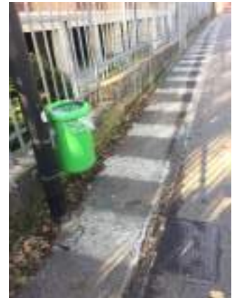
B1. 13 Ostacolo su percorso pedonale
