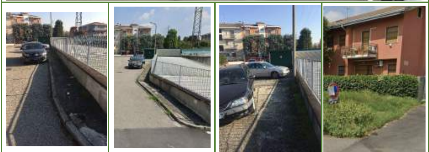
B1. 6- attraversamento stradale, Manca cartello divieto di sosta
