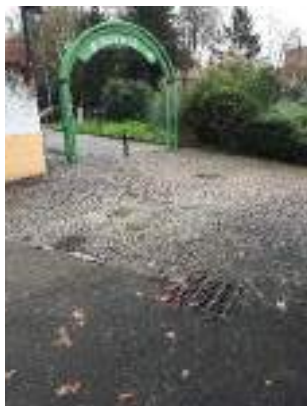
B1.4 Pavimentazione dissestata e sconnessa
