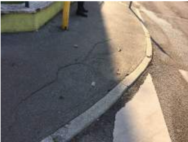
B1- 4 pavimentazione dissestata e sconnessa
