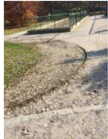
B1-11 Eliminare dislivello e portare a raso
