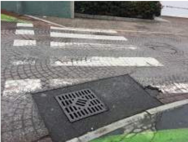
B1.4 pavimentazione dissestata
