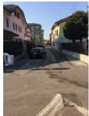
B1.6 Manca attraversamento pedonale
