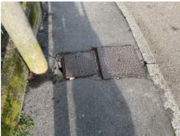
B1.5 pozzetto in sporgenza
