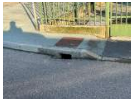
B1.2 eccessiva pendenza rampa
