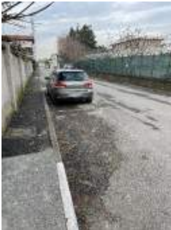
B1.4 dissesto pavimentazione
