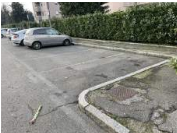
B1.4 dissesto pavimentazione
