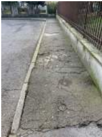
B1.4 dissesto pavimentazione
