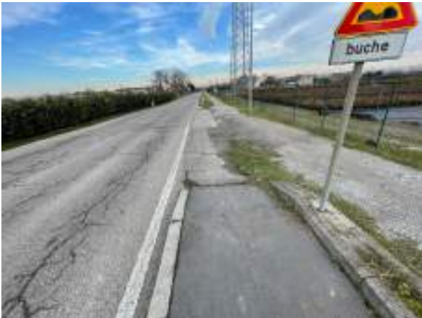
B1.4 dissesto pavimentazione
