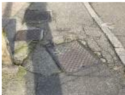
B1.5 pozzetti in sporgenza
