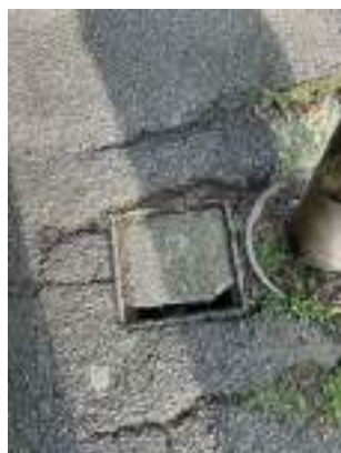
B1.5 pozzetti in sporgenza
