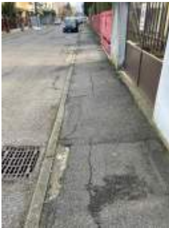
B1.4 dissesto pavimentazione
