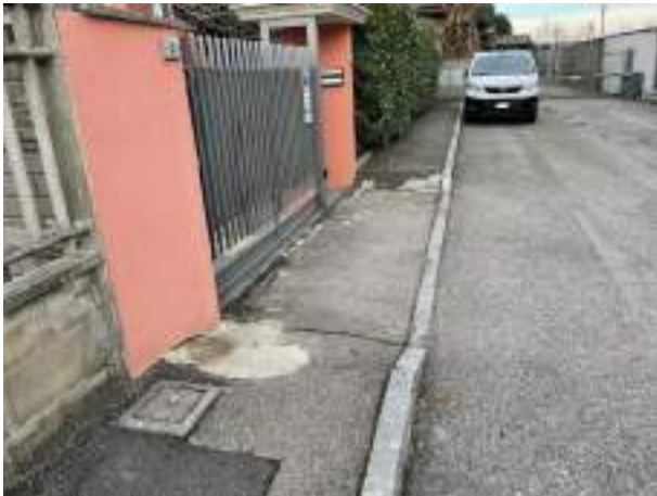
B1.4 dissesto pavimentazione
