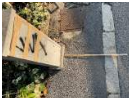
B1.2 eccessiva pendenza rampa
