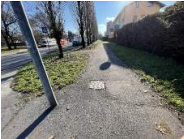
B1.5 pozzetto in sporgenza
