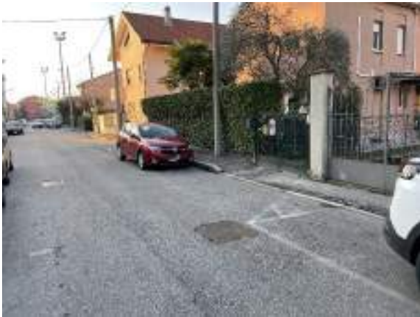
B1.4 dissesto pavimentazione
