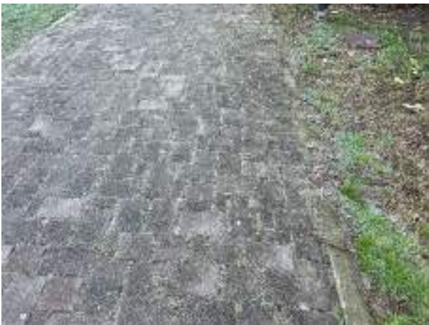
B1.4 dissesto pavimentazione
