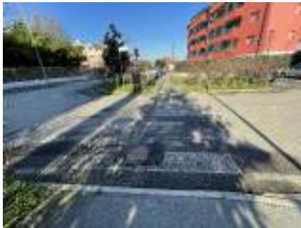
B1.4 dissesto pavimentazione
