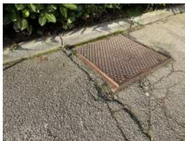
B1.5 pozzetti in sporgenza
