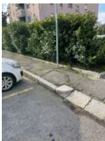
B1.4 dissesto pavimentazione
