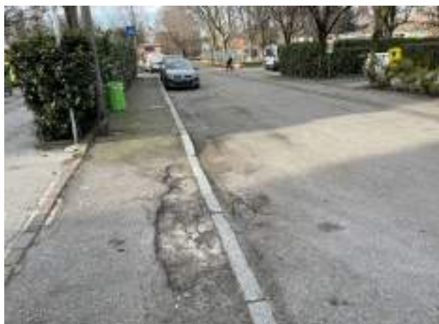
B1.4 dissesto pavimentazione
