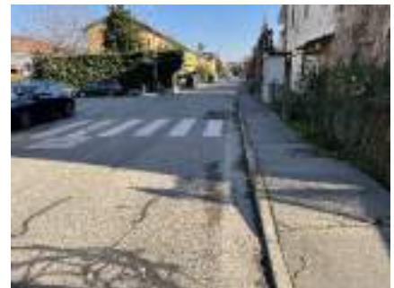
B1.4 dissesto pavimentazione
