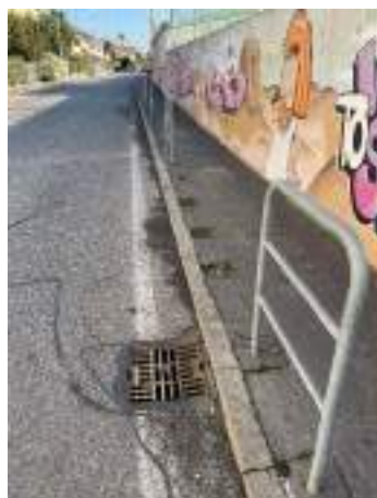
B1.4 dissesto pavimentazione
