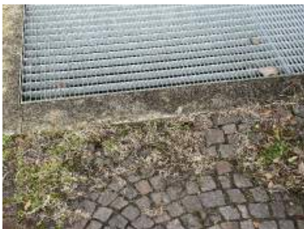
B1.4 dissesto pavimentazione
