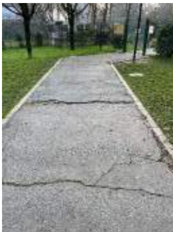
B1.4 dissesto pavimentazione
