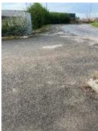
B1.21 Nuovo attraversamento pedonale
