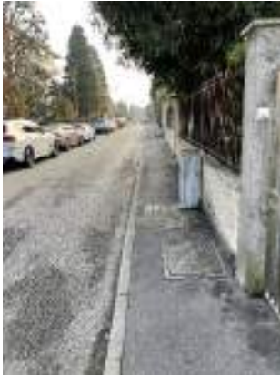
E108 pozzetto in sporgenza
