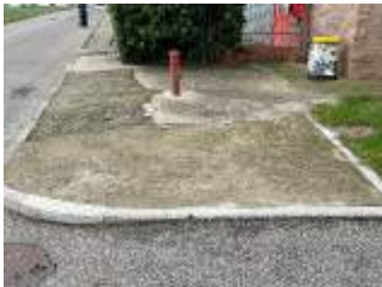
B1.4 Dissesto pavimentazione
