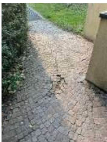
B1.4 - Dissesto pavimentazione
