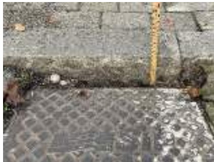
B1.5 pozzetto in sporgenza
