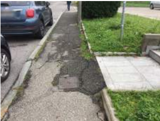
B1.4 pavimentazione dissestata
