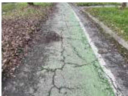
B1.4 dissesto pavimentazione
