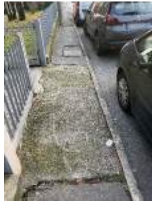
E113 B1.5 pozzetto in sporgenza
