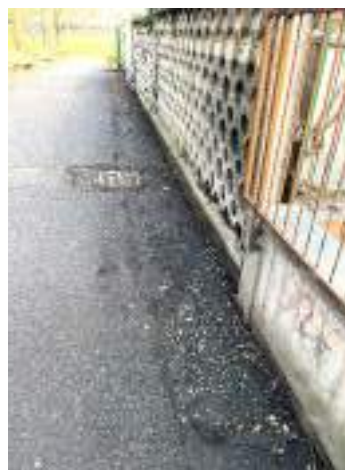
B1.5 pozzetto in sporgenza
