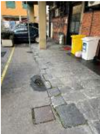
B1.4 dissesto pavimentazione
