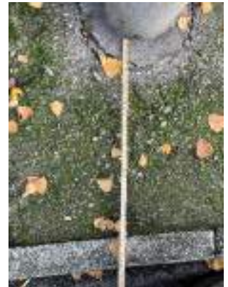
E111 pozzetto in sporgenza
