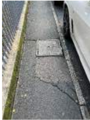
E109 pozzetto in sporgenza
