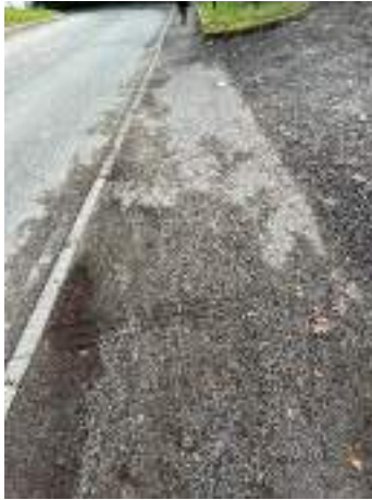
B1.4 dissesto pavimentazione
