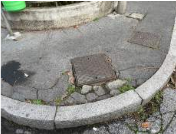
B1.4 pavimentazione degradata
