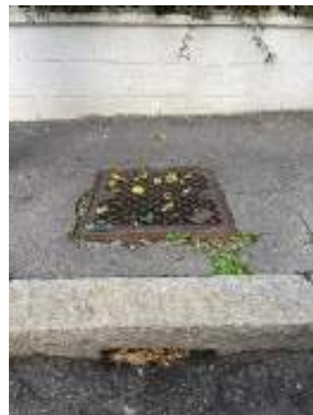
B1.5 pozzetto in sporgenza
