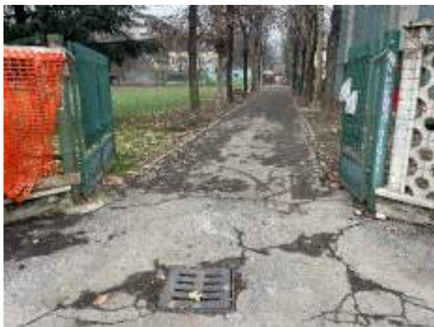
B1.4 Dissesto pavimentazione
