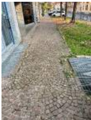
B1.4 dissesto pavimentazione
