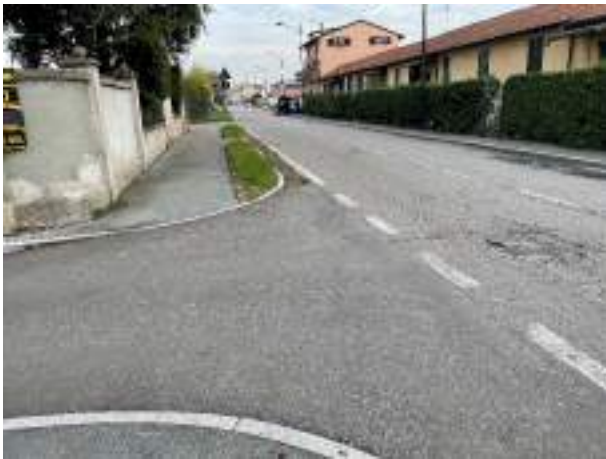
B1.21 Nuovo attraversamento pedonale
