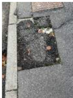
E105 B1.4 dissesto pavimentazione
