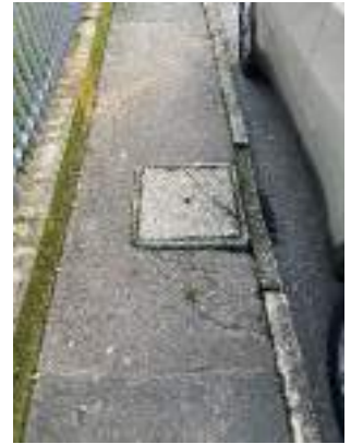
E111 pozzetto in sporgenza
