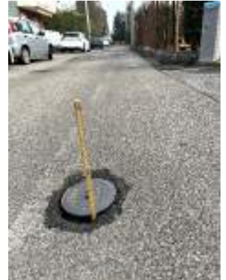
B1.5 pozzetto in sporgenza
