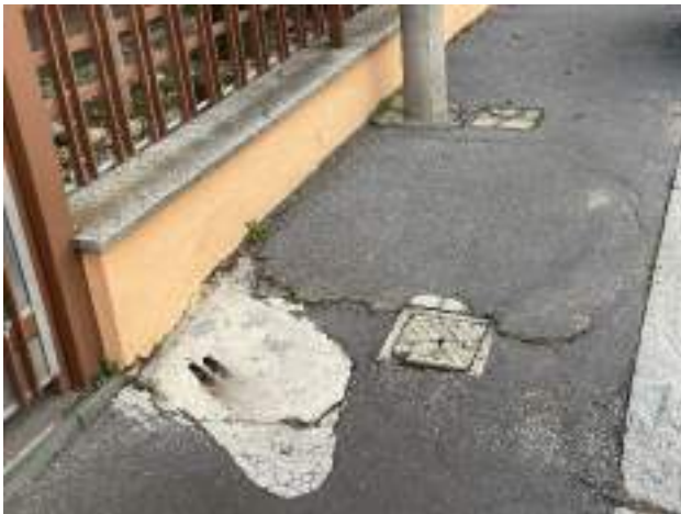
B1.4 Dissesto pavimentazione
