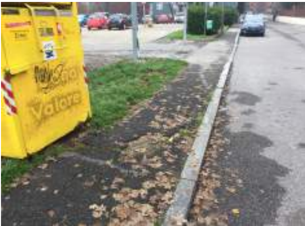
B1.4 dissesto pavimentazione
