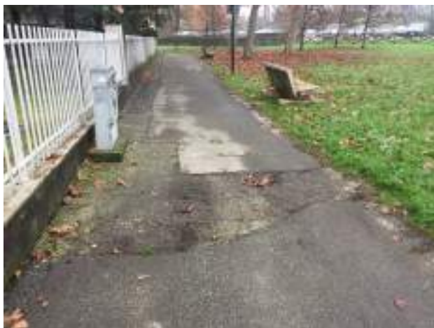
B1.4 pavimentazione dissestata e sconnessa
