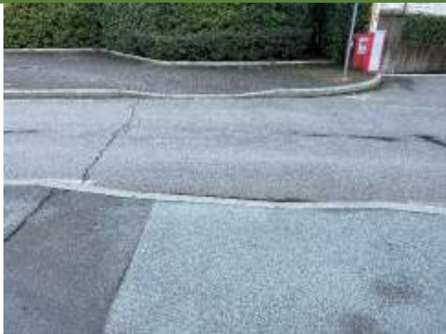
B1.6 mancanza segnaletica tattile e segnaletica orizzontale su attraversamento pedonale
