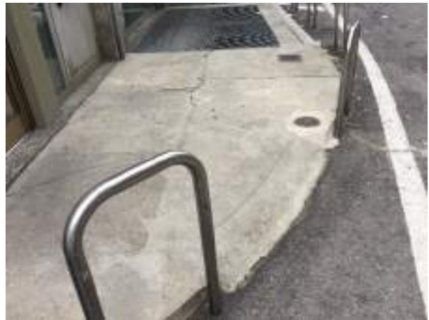
B1.4 rampa con eccessiva inclinazione
