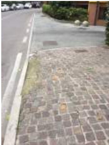
B1.4 - dissesto pavimentazione
