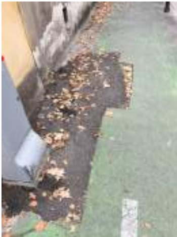
B1.4 dissesto pavimentazione
