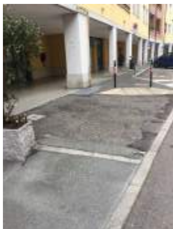
B1.4 – pavimentazione degradata e sconnessa
