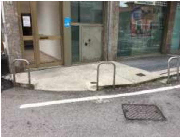
B1.4 pavimentazione dissestata
