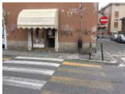
B1.4 – pavimentazione degradata e sconnessa
