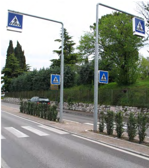
esempio di attraversamento pedonale protetto
