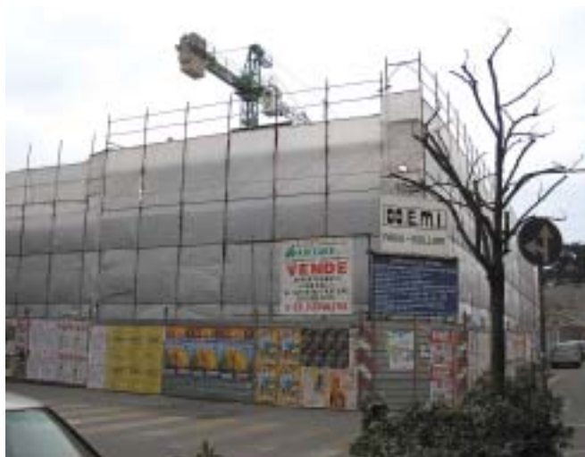
I lavori di via Repubblica 80
