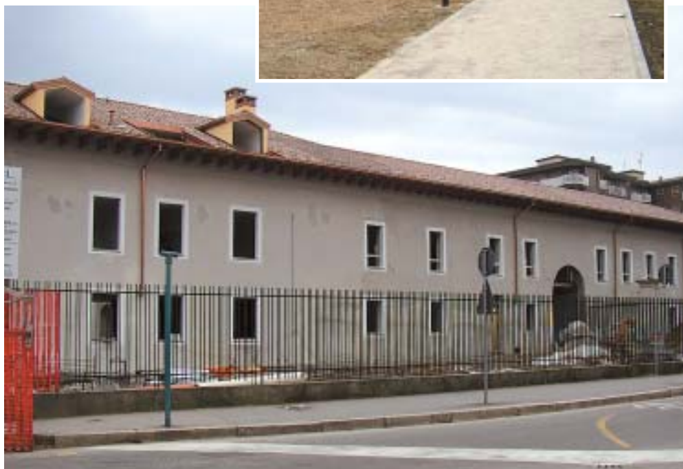
I lavori a Villa Venino
