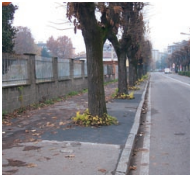
Sistemazione del marciapiede di via Rimembranze
