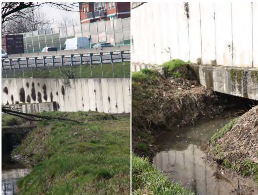
Foto 1: Garbogera sbocco sotto l'autostrada – Particolare dello sbocco
