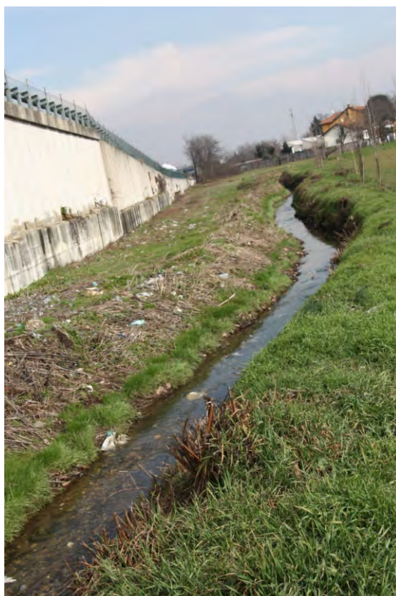
Foto 2: Garbogera tratto di valle che costeggia l'autostrada
