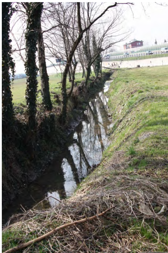
Foto 3: Garbogera tratto libero perpendicolare all'autostrada
